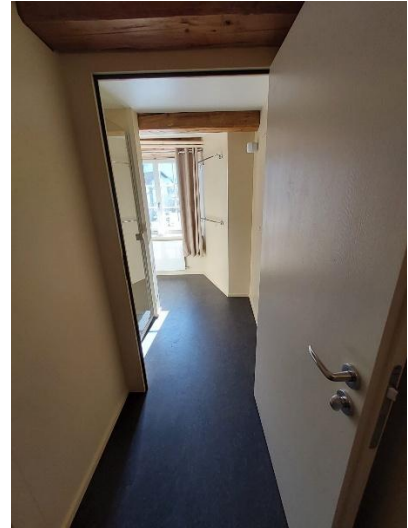
Blick ins neue Bad
