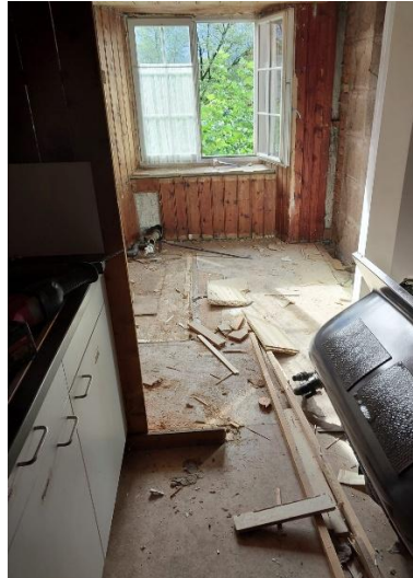
Abbruch des ehemaligen Bads
