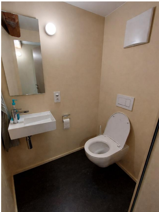
Errichtung einer neuen (zweiten) Toilette
