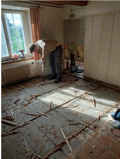
Abbrucharbeiten im Zimmer 6
